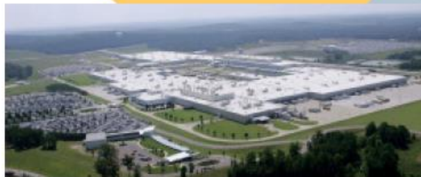
Tuscaloosa, AL Fahrzeugmontage
